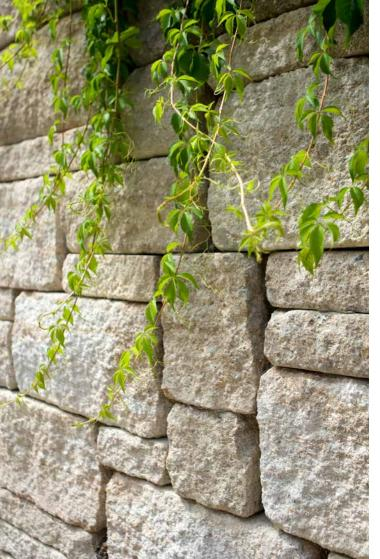
▲ linear | verschiedene Abmessungen | Grau-Schwarz | Schichtenmauerwerk
