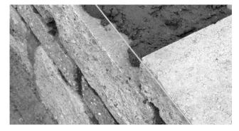
Fugenmörtel, der aus den Fugen austritt und die Ansichtsflächen der Mauersteine verschmutzt, wird nach und nach während des Aufbaus der Mauer mit einem nassen Schwamm abgetupft und entfernt.
