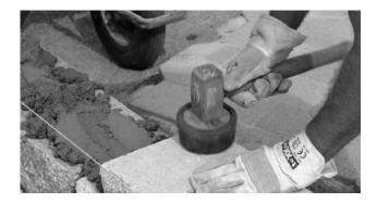
Die Stoßfugen zwischen den einzelnen Steinen werden dabei fortlaufend mit dem Fugenmörtel von oben mit einer Maurerkelle bis zur Oberkante gefüllt.
