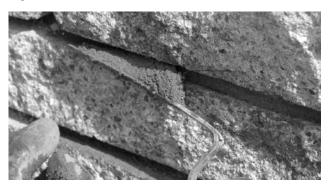
Nachdem die erste Reihe versetzt worden ist, wird der Fugenmörtel auf die Oberfläche der ersten Steinreihe aufgetragen und die zweite Steinreihe kann versetzt werden. Dabei muss die Schnur wieder neu angepasst werden. So wird kontinuierlich weiter verfahren, bis die Mauer fertiggestellt ist.
